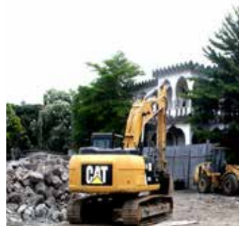
▲ Opération de remblaiement à El-Maarouf
